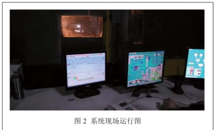
在转炉挡火墙上，火焰图像分析模块装于主控室观察窗上方，加速度传感器分别安装在A、B氧枪上；多频段音频分析仪、振动信号分析仪和工控机安装在主控室中，并从主控室中接入转炉PLC信号和转炉数据库信号。系统在C钢厂6#转炉的现场运行稳定，如图2所示。
