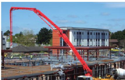
可以将混凝土输送到普通水泥罐车或泵送机械难以或无法到达的位置。霍尼韦尔重载限位开关(HDLS系列)用于检测杆梁位置。当杆梁正确就位时,限位开关就会向操作员发送一个信号。
