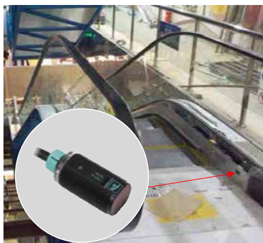
图 9 用于进出口检测的 GLV18 系列光电开关
